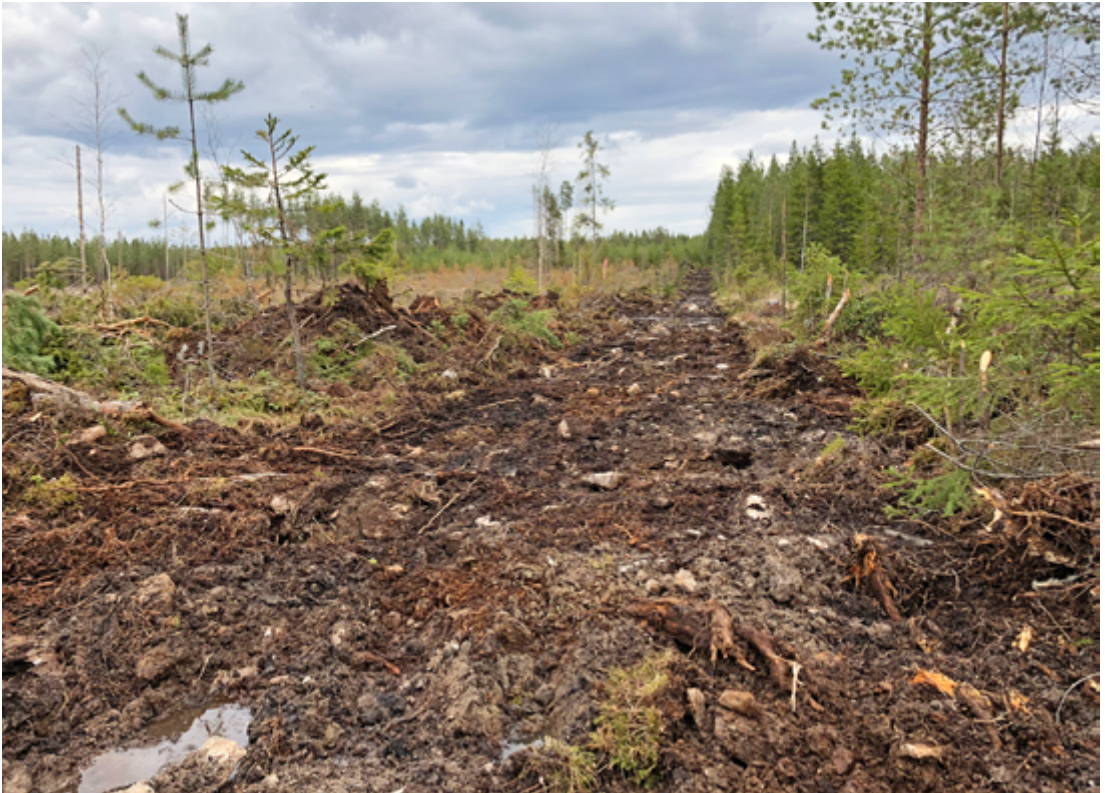
Kuva 5. Palokujan tulee ulottua koko matkalta kivennäismaahan saakka ja sopiva leveys on noin 2-3 m (Kuva: Jussi Laurila).
